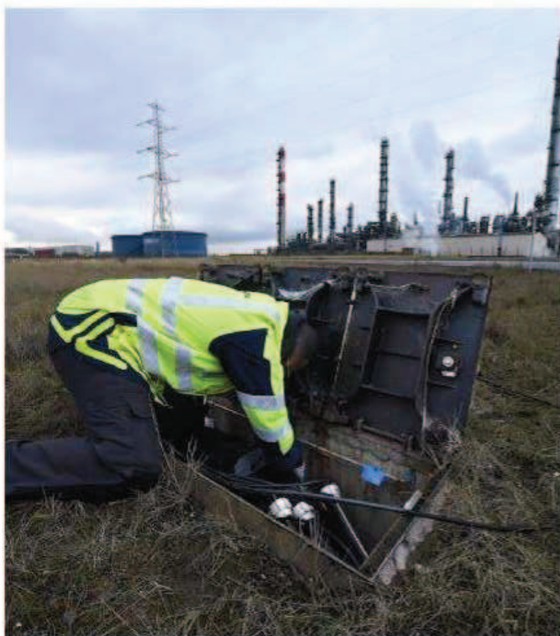
Covage a installé de la fibre optique dans l'agglomération dunkerquoise.
